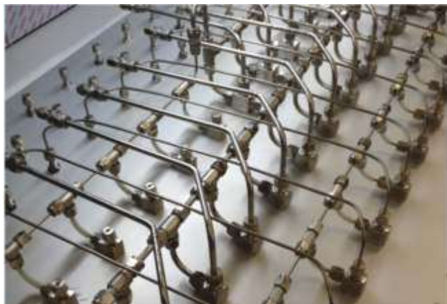
Рис. 35. Пример монтажа блоков стенда
